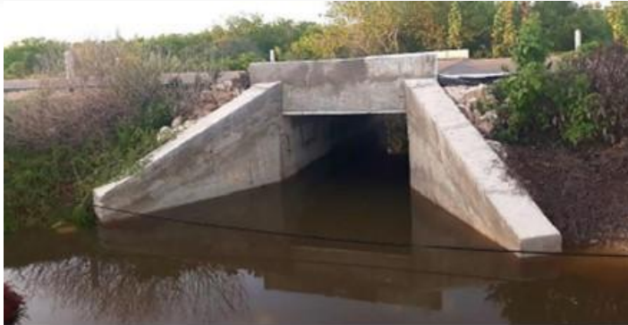
Desasolve de pasos de agua
