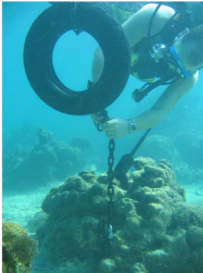
FOTOGRAFÍA 22. INSTALANDO UNA LLANTA USADA EN LA CADENA PARA SERVIR COMO AMORTIGUADOR
