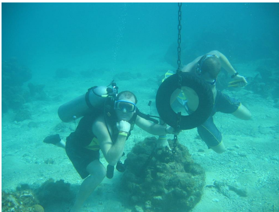
FOTOGRAFÍA 24. LA LLANTA USADA QUE SIRVE COMO AMORTIGUADOR YA INSTALADA EN LA CADENA
