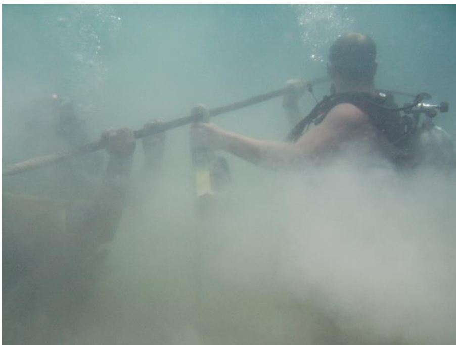
FOTOGRAFÍA 19. DOS BUZOS INSTALANDO TORNILLO DE ARENA
