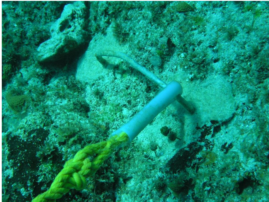
FOTOGRAFÍA 14. OTRO TIPO DE FIJACION CON BARRA DE ACERO INOXIDABLE
