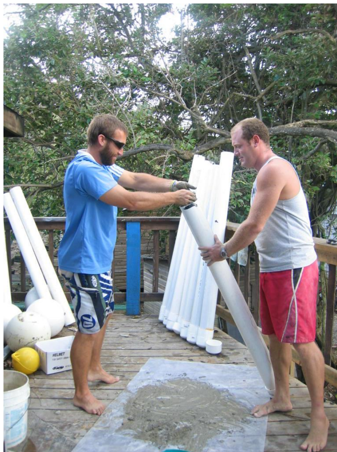
FOTOGRAFÍA 25. LLENANDO LA PARTE INFERIOR DE LA BOYA DE MARCACIÓN DE CANALES PARA QUE LA MISMA SE MANTENGA SIEMPRE EN LA MISMA POSICIÓN
