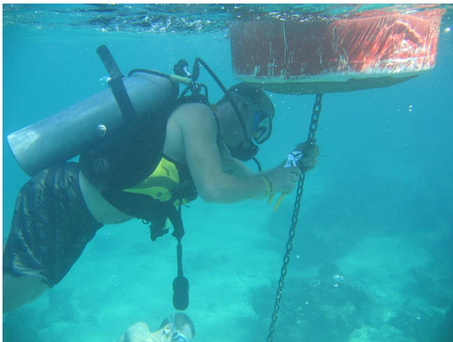
FOTOGRAFÍA 23. AJUSTANDO LOS SHACKLES BAJO EL AGUA
